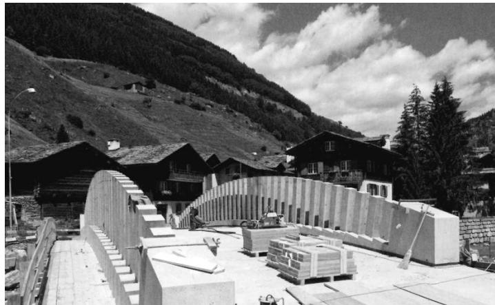
Figg. 10-11 Valserrheinbrücke, 2010: posa in opera delle lastre in pietra di Vals [foto di Wilfried Dechau, tratta da AA. VV., 2010. Dorfbrücke Fotografisches Tagebuch . Tübingen/Berlin: Ernst Wasmuth Verlag, p. 123, p. 50].
