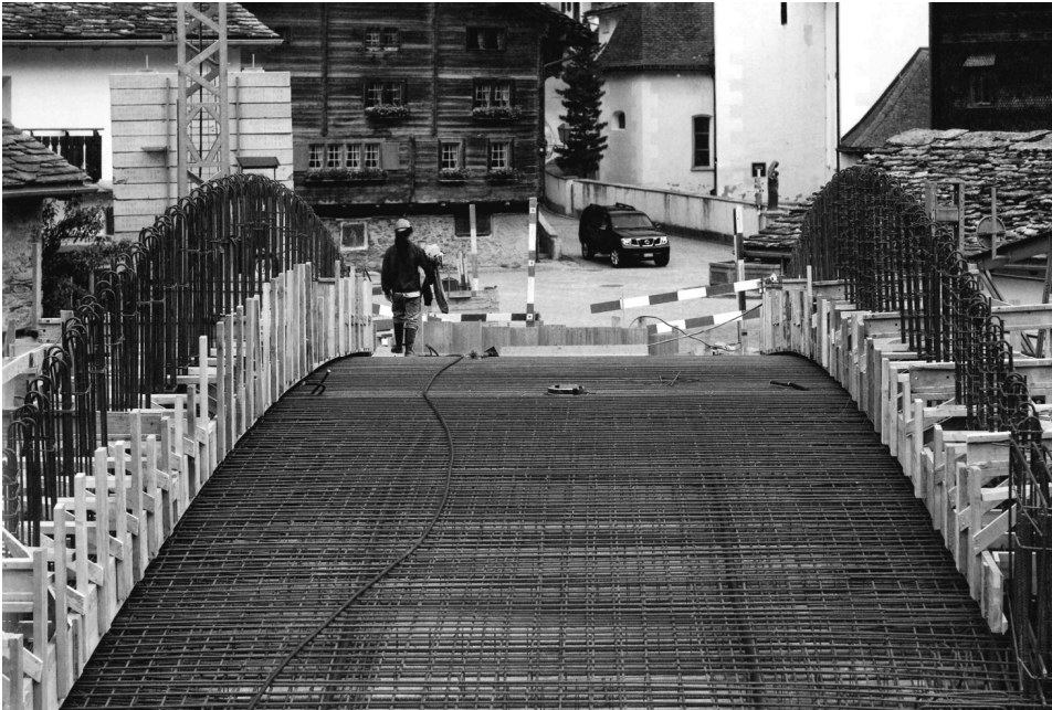
Fig. 9 Valserrheinbrücke, 2010 : la costruzione del pavimento “sospeso” alle travi [foto di Wilfried Dechau, tratta da AA. VV., 2010. Dorfbrücke Fotografisches Tagebuch . Tübingen/Berlin: Ernst Wasmuth Verlag, p. 109].
