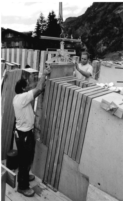
Figg. 10-11 Valserrheinbrücke, 2010: posa in opera delle lastre in pietra di Vals [foto di Wilfried Dechau, tratta da AA. VV., 2010. Dorfbrücke Fotografisches Tagebuch . Tübingen/Berlin: Ernst Wasmuth Verlag, p. 123, p. 50].
